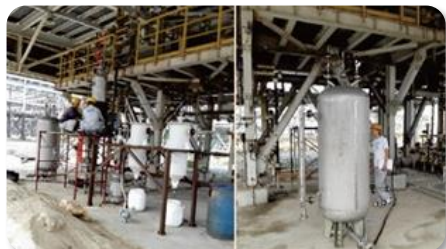
固体废弃处理
