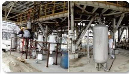
固体废弃处理
